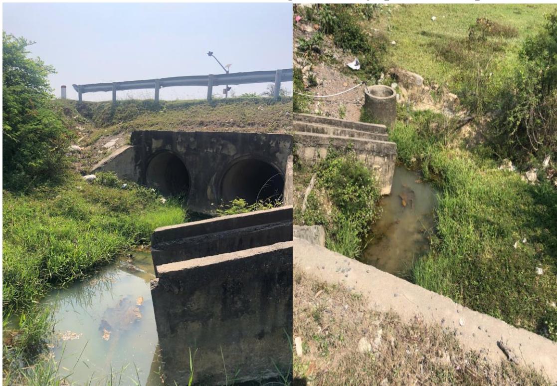
Hình 3.2: Hình ảnh mương thoát nước phía bên dự án
